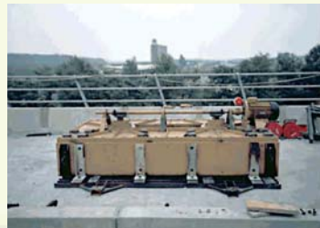
INDAGINE PER LA DETERMINAZIONE DEL COMPORTAMENTO DINAMICO DI UN VIADOTTO FERROVIARIO CON PILE IN C.A. ED IMPALCATO IN C.A.P. - SOCIETA ITALIANA CONDOTTE D'ACQUA S.P.A. - LINEA FERROVIARIA AD ALTA VELOCITA TRATTA BOLOGNA-VERONA
