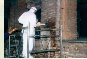
PREPARAZIONE PROVA CON MARTINETTI PIATTI PALAZZO DI GIUSTIZIA - BOLZANO
