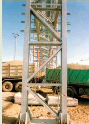
ALENIA S.P.A. PROVA DI CARICO A TIRO SU TRALICCIO NAPOLI
