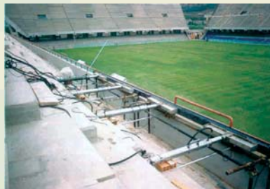
COMUNE DI SALERNO PROVA A SPINTA SU PARAPETTO STADIO ARECHI
