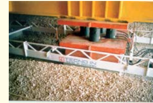
STRUMENTAZIONI PER PROVA SU PALO LINEA AD ALTA VELOCITÀ TRATTA ROMA - NAPOLI
