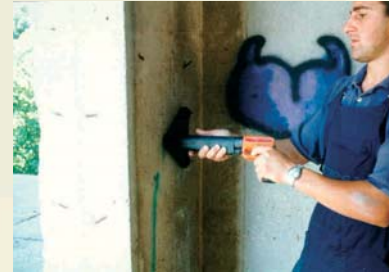
A.N.A.S. S.P.A. - LAZIO PROVA WINDSOR - PONTE DI ARICCIA (RM)
