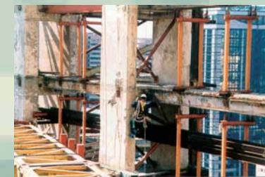
PROVVEDITORATO OO.PP. REGIONE CAMPANIA INDAGINI STRUTTURALI CON PRELIEVO DI CAMPIONI SULLA "TORRE A" DEL PALAZZO DI GIUSTIZIA DI NAPOLI INTERESSATA DA INCENDIO
