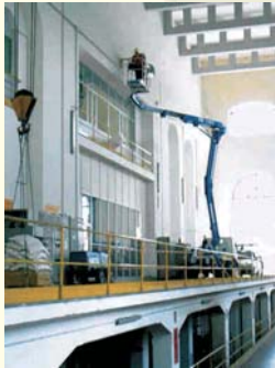
ENEL POWER S.P.A. PRELIEVO DI CAMPIONI CILINDRICI DI CALCESTRUZZO CENTRALE IDROELETTRICA VOLTURNO 1 ROCCHETTA (IS)
