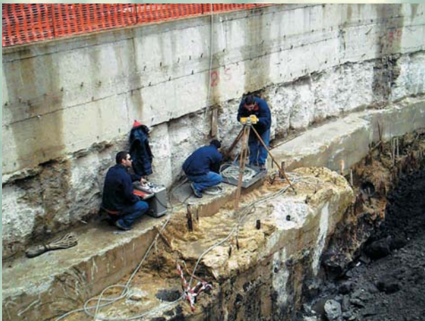
PROVE CROSS-HOLE - METROPOLITANA DI NAPOLI S.P.A. - LINEA 1 - STAZIONE UNIVERSITÀ
