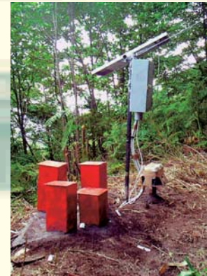
FRANA DI SARNO (SA) - POSTAZIONE DI MONITORAGGIO REMOTO
