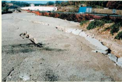
ANAS S.P.A. - MONITORAGGIO ASSESTIMETRICO ED INCLINOMETRICO DI UN RILEVATO DELL'AUTOSTRADA A3 SALERNO - REGGIO CALABRIA, CON RICOSTRUZIONE DELLE SUPERFICI DI SCORRIMENTO
