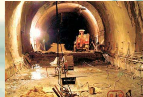
CANTIERE R.F.I. S.P.A. - INSTALLAZIONE DI STRUMENTAZIONE PER MONITORAGGIO SEZIONI DI GALLERIA (CELLE DI CARICO E STRAIN GAUGES IN CORRISPONDENZA DELLE CENTINE, CELLE DI CARICO SU TIRANTI, CELLE DI PRESSIONE, ESTENSIMETRI IN FORO MULTIBASE, ASSESTIMETRI INCREMENTALI)
