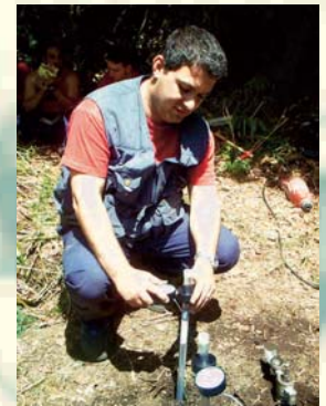
FRANA DI SARNO (SA) - INSTALLAZIONE TENSIOMETRI
