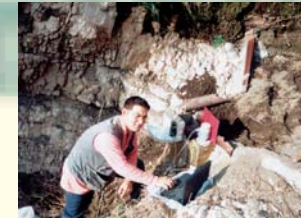
FRANA DI SARNO (SA) - ACQUISIZIONE DATI DI PORTATA IDRICA
