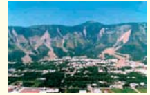
PROVEDITORATO OO.PP. REGIONE CAMPANIA MONITORAGGIO DEI PENDII IN FRANA NELL'INTORNO DI PIZZO D'ALVANO IN SARNO (SA), A SEGUITO DEGLI EVENTI ALLUVIONALI DEL 5 MAGGIO 1998
