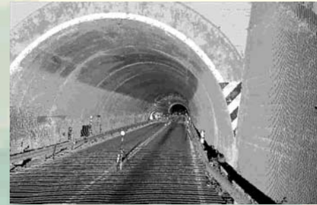
RILIEVO 3D - PRINCIPALI GALLERIE AUTOSTRADALI A.N.A.S. S.P.A.
