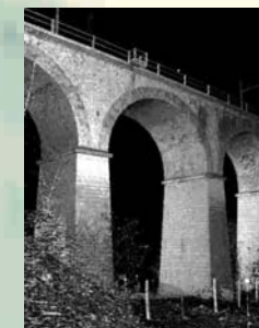
VIADOTTO FERROVIARIO - R.F.I. S.P.A. LINEA FERROVIARIA ROMA - SULMONA CAROLI (AQ)
