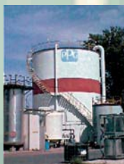
RILIEVO DEL SERBATOIO IDRICO - PPG INDUSTRIES ITALIANE S.r.l. - CAIVANO (NA)
